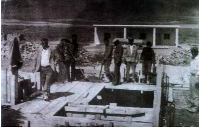
TAKSAN Kayseri fabrikası temel atma
